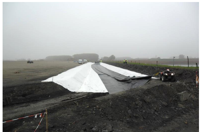
Figure 10. Bassins G2 – Mise en œuvre du géotextile de renforcement suivi de la géomembrane au sein des fossés (Mai 2012).
