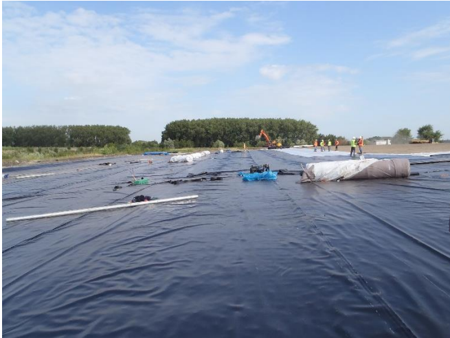
Figure 11. Bassins G2 – Pose de la géomembrane sur les dômes (Juin 2012).
