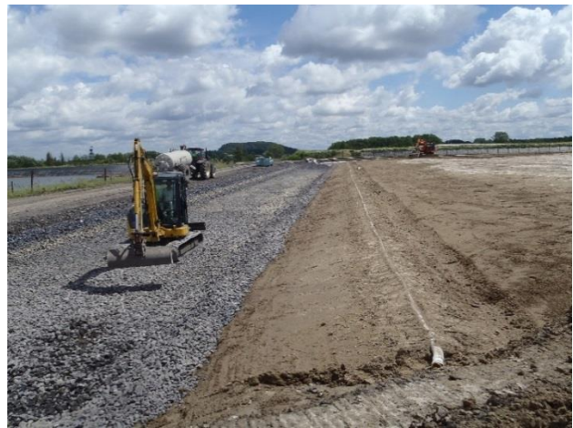
Figure 16. Bassins G2 – Couverture après reprise des ravines et création d'une cunette » afin de gérer le ruissellement des eaux pluviales (Juillet 2012).
