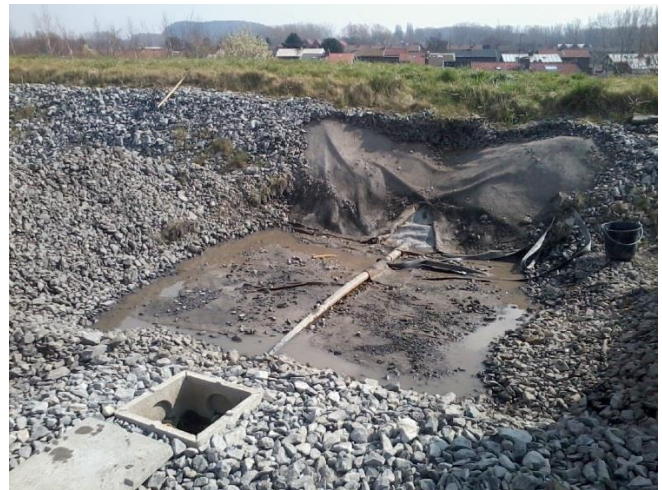
Figure 12. Bassins G3 – Illustration du dispositif d'ajutage en point bas de fossé.
