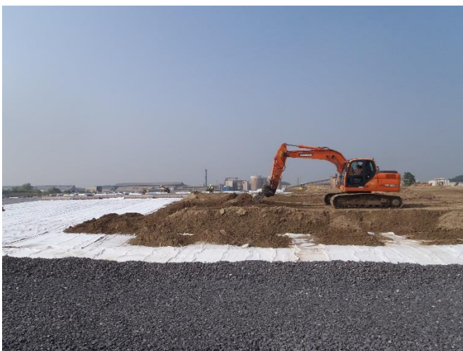
Figure 13. Bassins G2 – Géosynthétique drainant posé et création des pistes de terre végétale en « arrêtes de poisson » (Juillet 2012).
