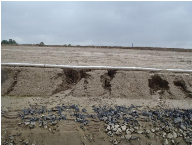
Figure 15. Bassins G2 – Apparition de ravines au sein de la terre végétale, au niveau du raccord entre dôme et fossé granulaire pluviales (Juillet 2012).
