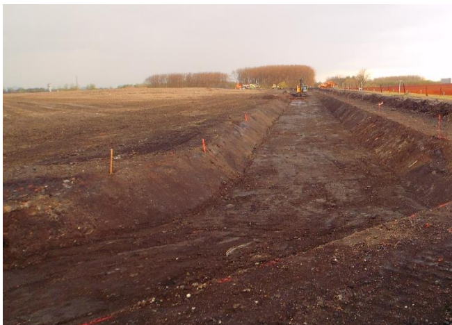
Figure 9. Bassins G2 – création des fossés de drainage et de tamponnement (Avril 2012).
